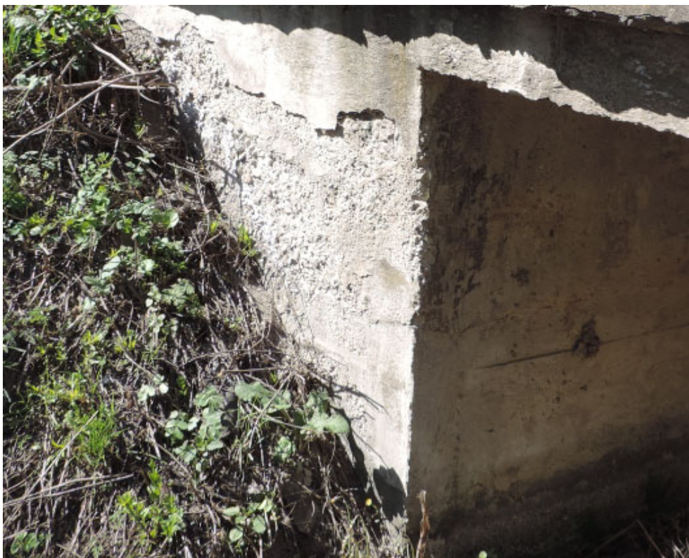
Obr. Poruchy spodnej stavby pravého mosta
