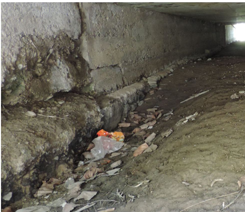
Obr. Poruchy spodnej stavby ľavého mosta
