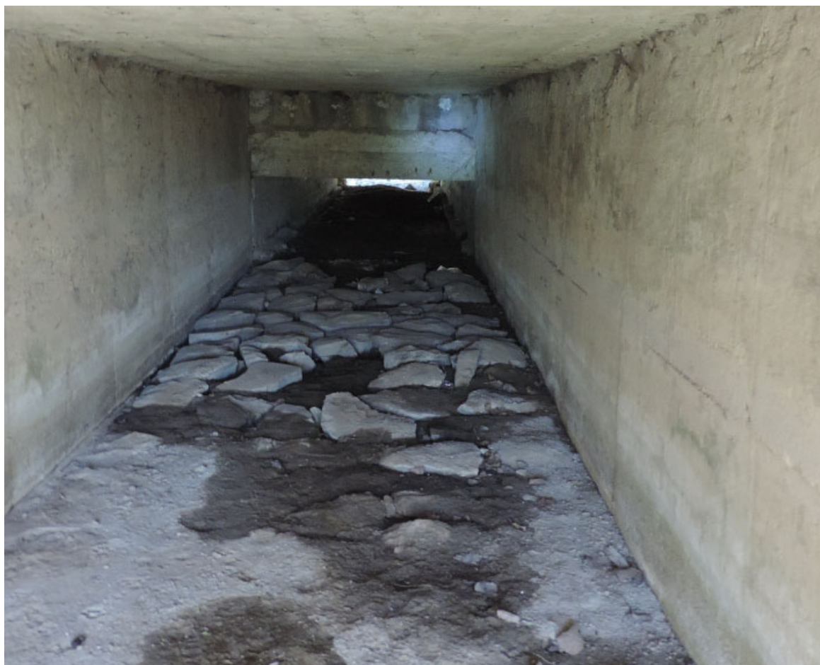
Obr. Poruchy koryta poľného jarku a kužeľov
