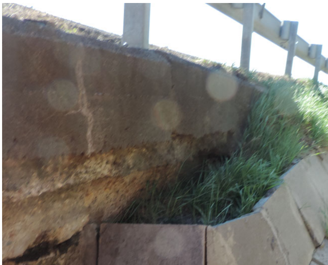
Obr. Poruchy mostného zvršku
