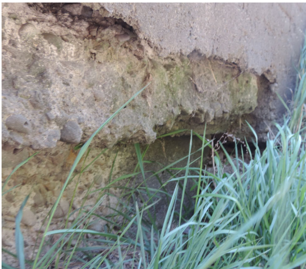
Obr. Poruchy na nosnej konštrukcii ľavého mosta
